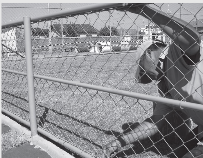
Funcionário trabalha nos retoques da área de lazer no Caju
