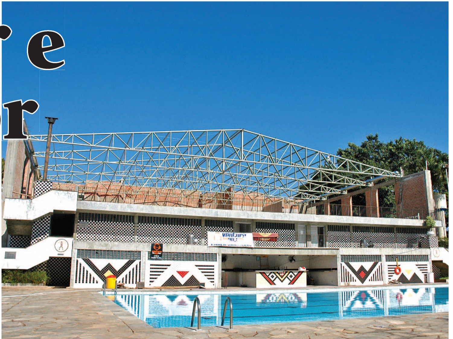
Vista central da construção do novo salão de festas
