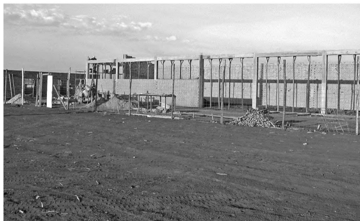
Obra do barracão que vai abrigar os catadores de recicláveis
