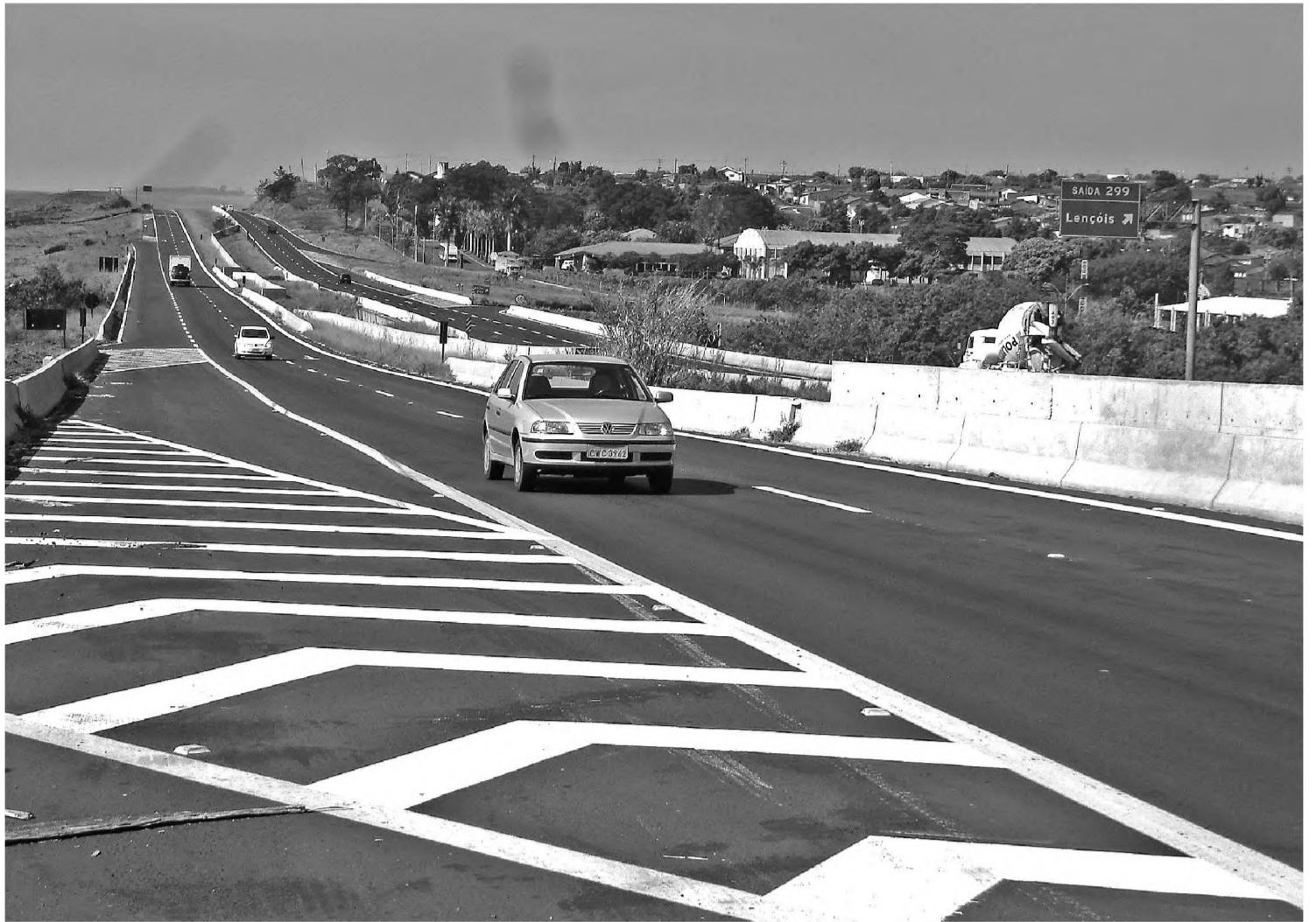
DER construiu muros entre as pistas da rodovia Marechal Rondon, no trecho ao longo do Jardim Primavera, para evitar travessia
