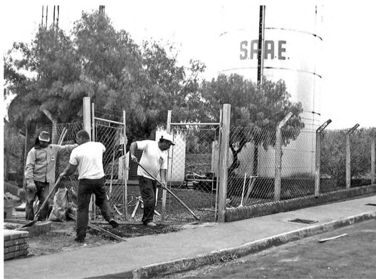
Funcionários trabalham em reforma das instalações do SAAE
