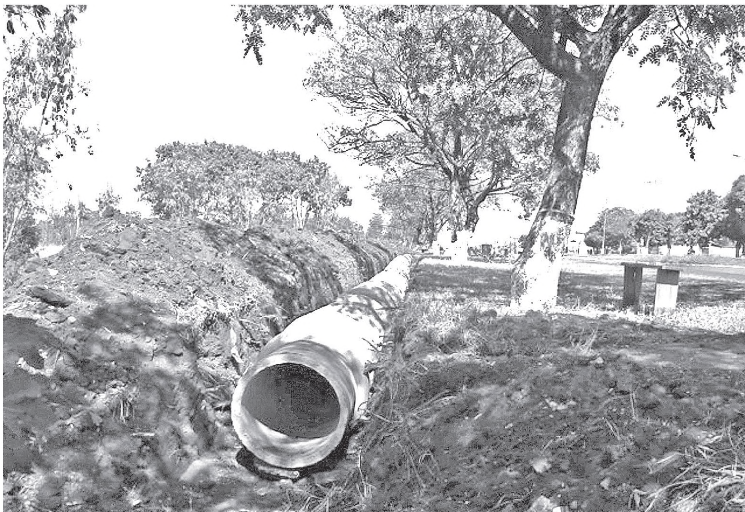
Tubulação de galeria para águas de chuvas que estão sendo instaladas na região próxima à rodovia Marechal Rondon, em Areiópolis
