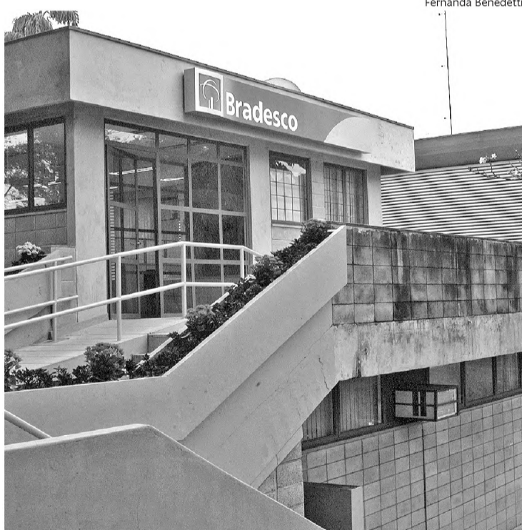
Vista geral do novo posto de atendimento do Bradesco
