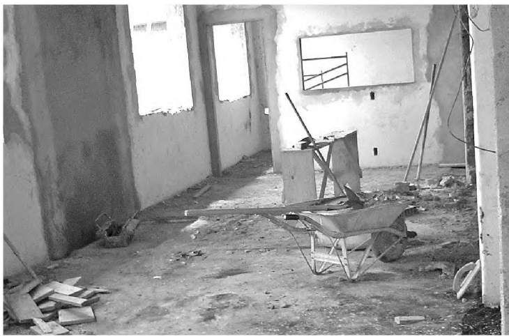
Depois de pronto, prédio que abrigará o paço terá 16 salas
