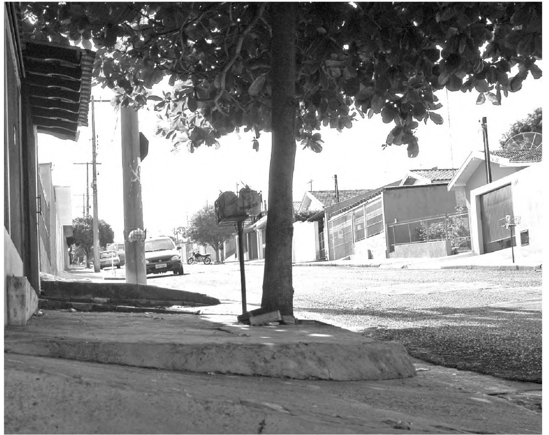
Prazo para comunicar que imóveis estão irregulares vai até dezembro; calçadas, beirais estão na lista
