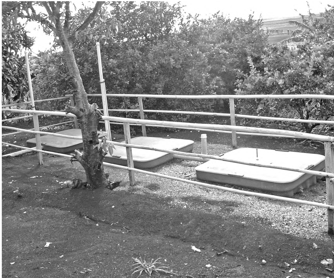
Fossa ecológica instalada na propriedade de Ermelindo de Souza Campos, em Macatuba
