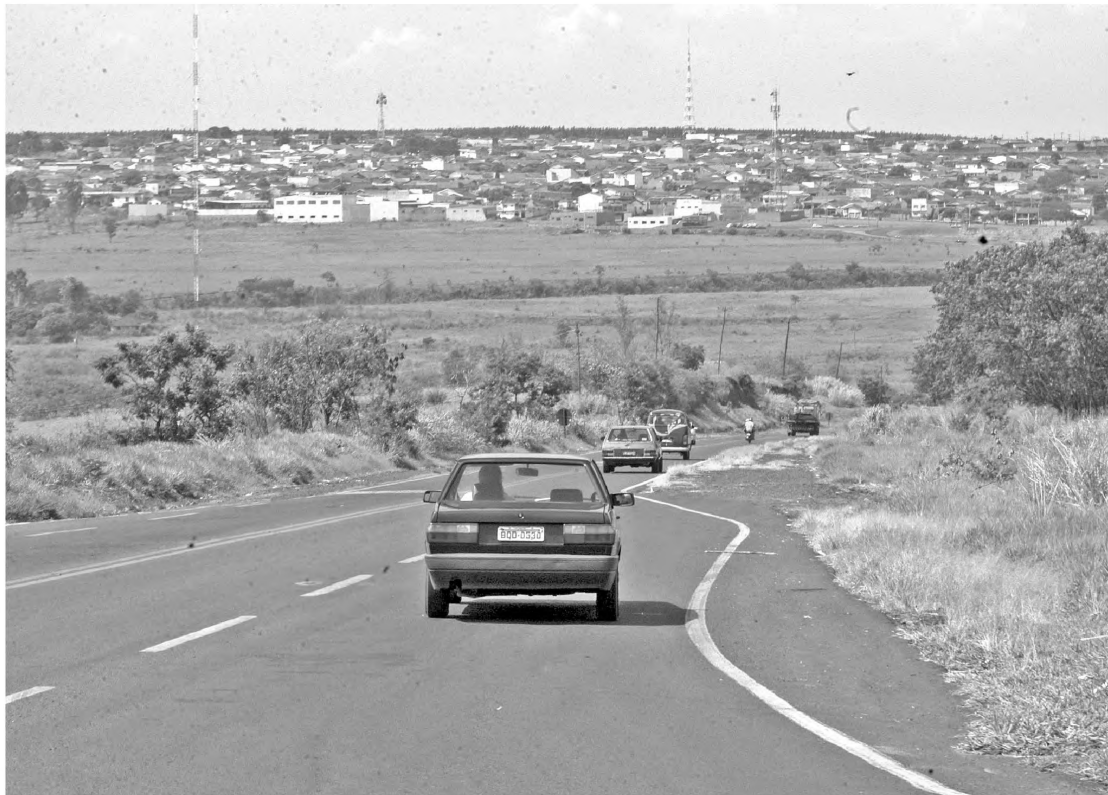
Trecho da rodovia Osny Matheus que deverá ganhar sinalização e reparos na pavimentação
