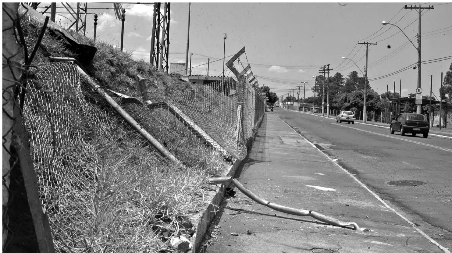
Avenida Lázaro Brígido, local onde o condutor de um Astra perdeu a direção e entrou no alambrado da subestação da CPFL
