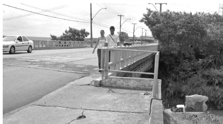
Local onde será instalada uma passarela metálica para pedestres
