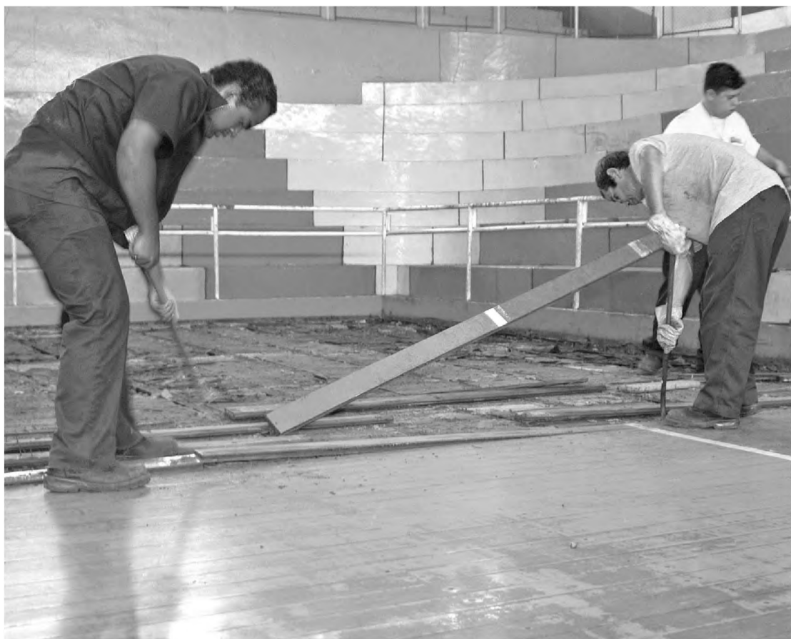
Homens trabalham na retirada do assoalho do Csec; quadra vai ganhar piso sintético
