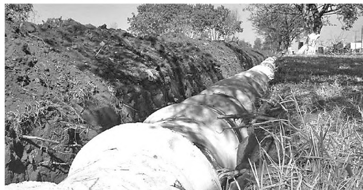
Obras das galerias pluviais que devem ficar prontas essa semana
