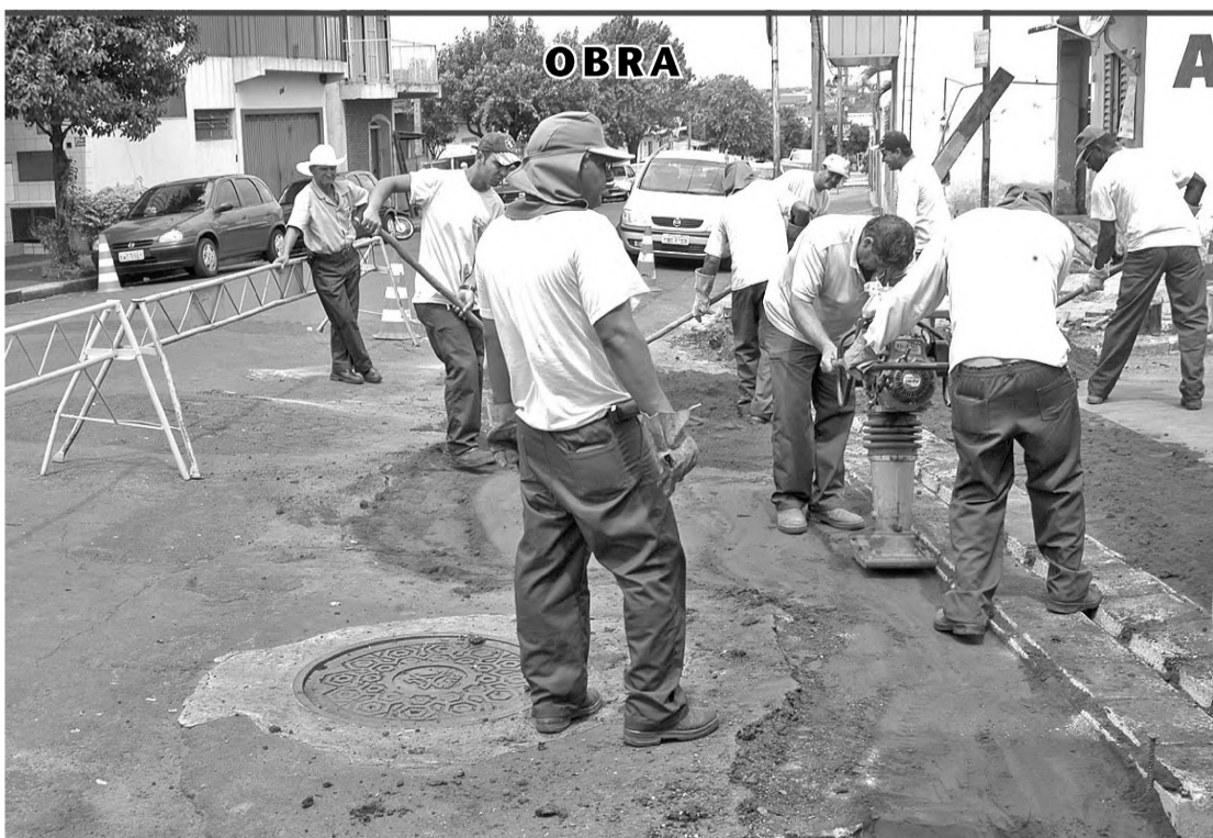
Na tarde de ontem, funcionários da Prefeitura de Lençóis Paulista trabalhavam na rua Coronel Joaquim Gabriel. A proposta era quebrar o asfalto e fazer um sarjetão para que a água da chuva não fique empoçada.
