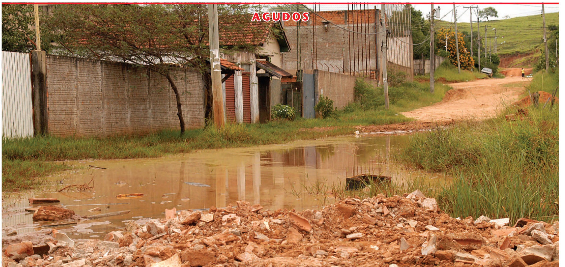
Vista geral da rua Lourival Ramos Santos, no Jardim Santa Cândida, onde a falta de guias, sarjetas, calçadas e asfalto tira o sono dos moradores há 26 anos
