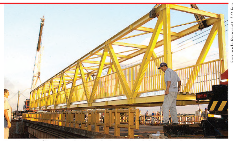
Ponte metálica que foi instalada no final da tarde de ontem
