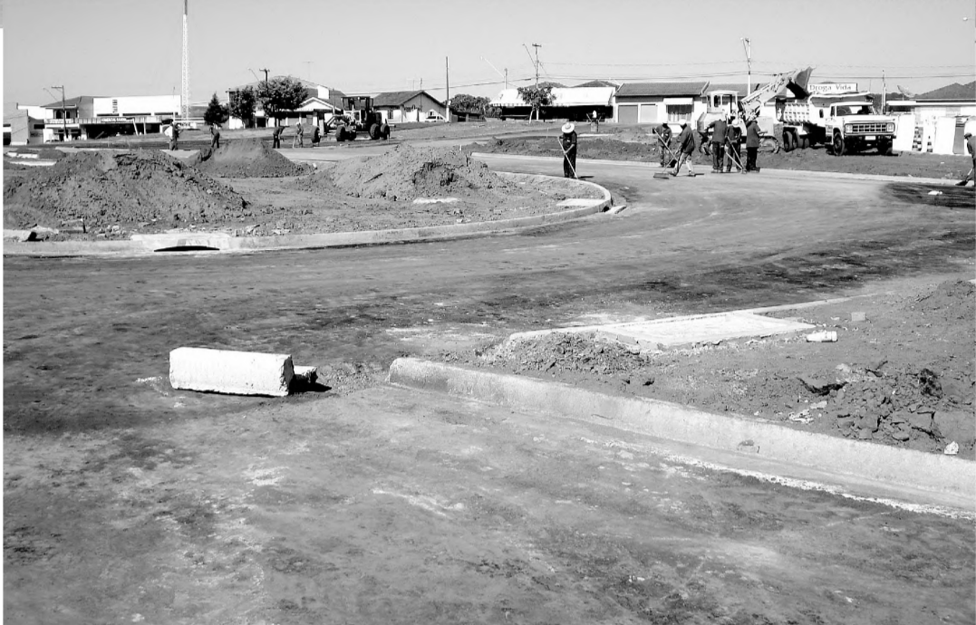
Funcionários da prefeitura de Agudos trabalham nas obras da avenida Carvalho Pinto
