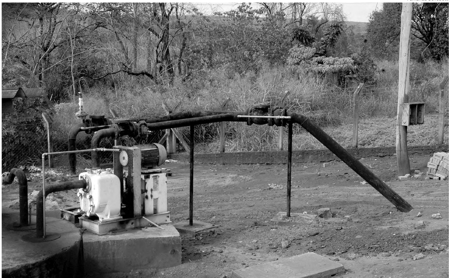
Aumento de consumo e vazamento na rede foram as causas para a falta de água no Jardim Caju neste final de semana
