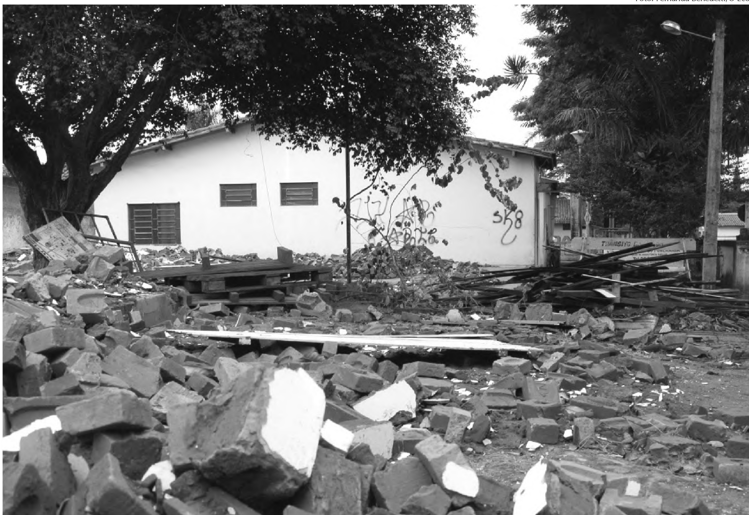
Prefeitura já demoliu dois prédios na área onde vai ser construída a nova unidade de saúde com custo estimado em R$ 1 milhão
