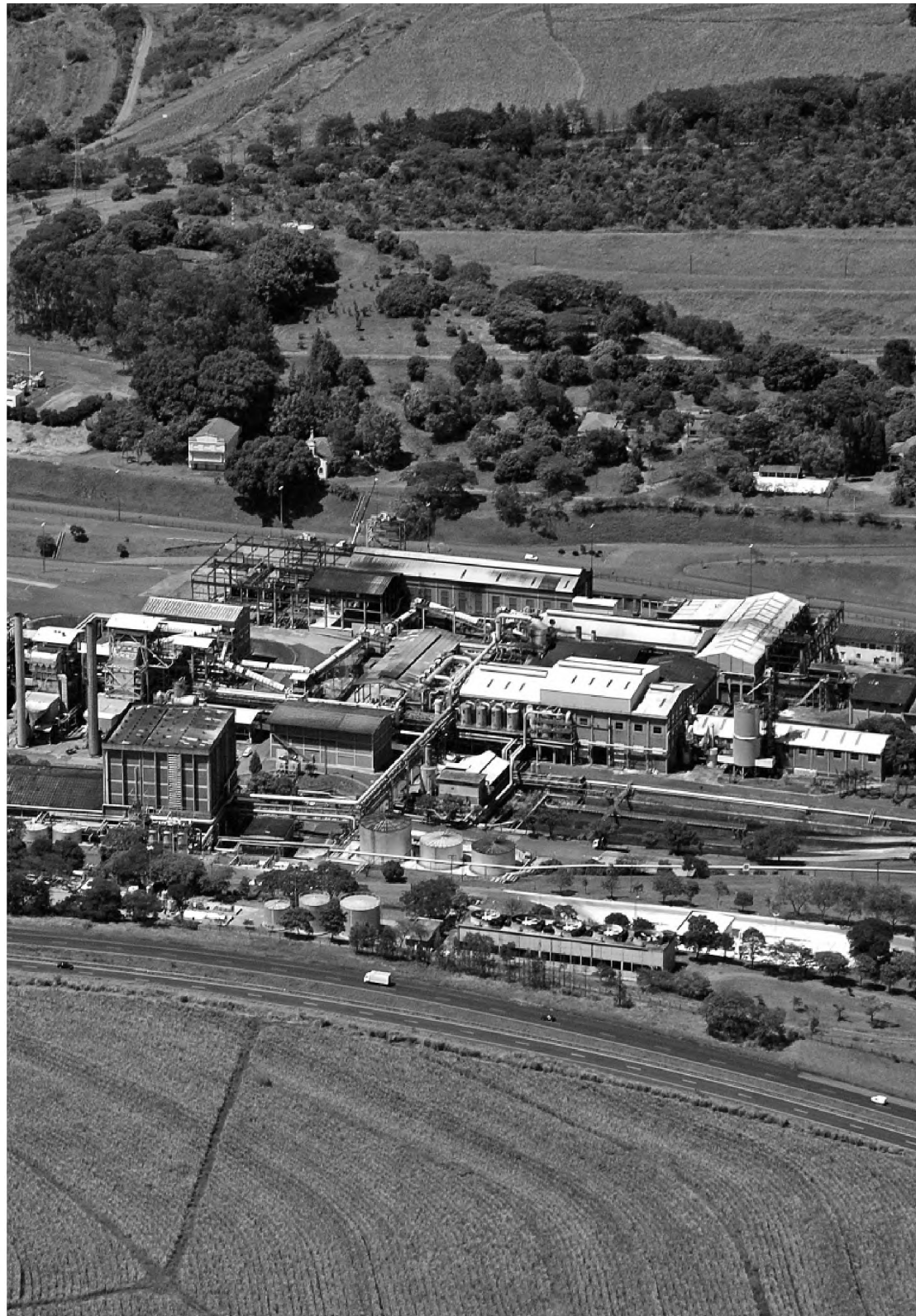
Vista aérea da usina Barra Grande, produtora de álcool, açúcar e energia
