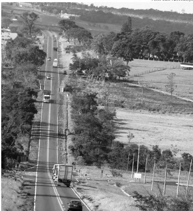
Vista da rodovia que liga Bauru a Piratininga, que será duplicada
