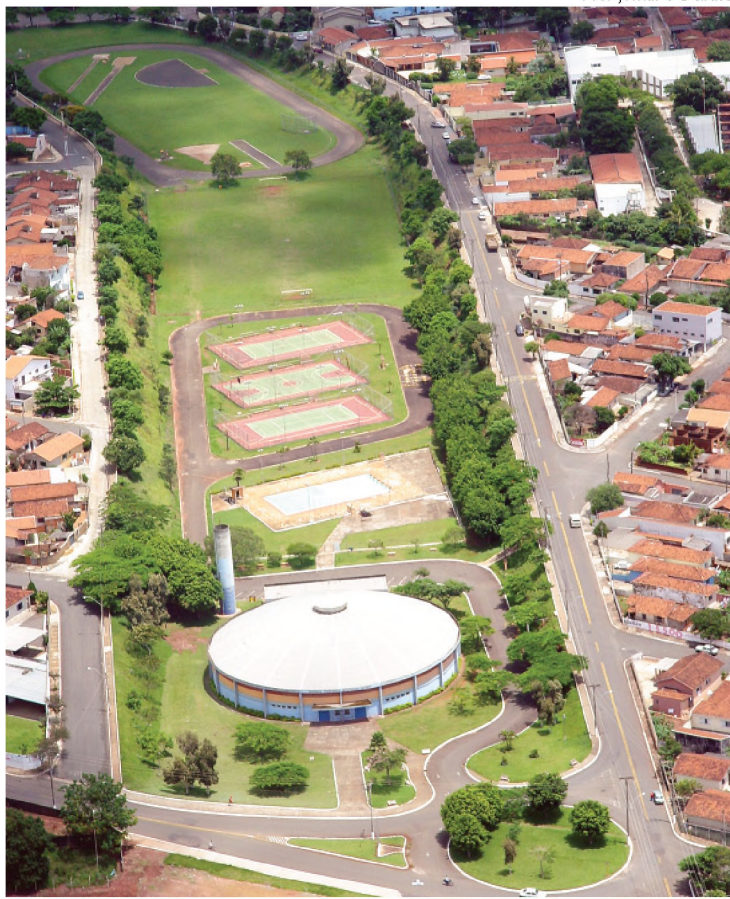
Vista aérea do Conjunto Poliesportivo Airton Senna
