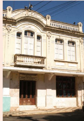
Fachada do prédio que deve ser restaurado
