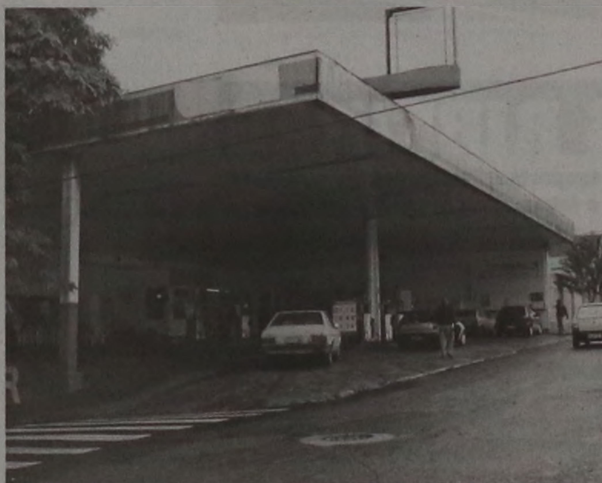
Prédio do Auto-Posto Vimabe foi arrematado por R$ 688 mil em leilão na quarta-feira
