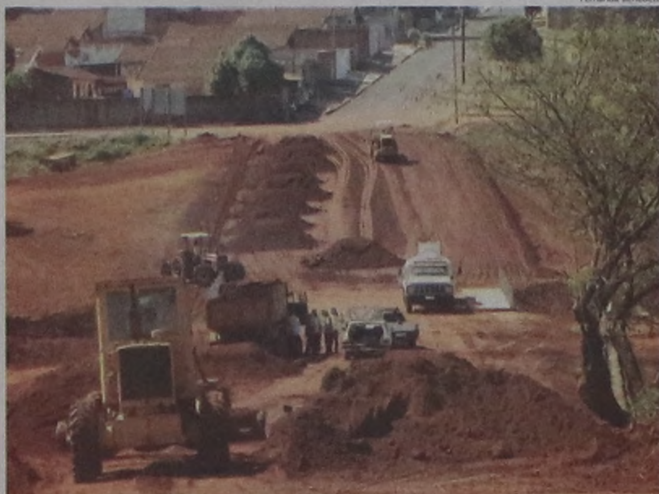
A ponte sobre o Rio da Prata deve ser entregue até o final de outubro e vai desafogar trânsito
