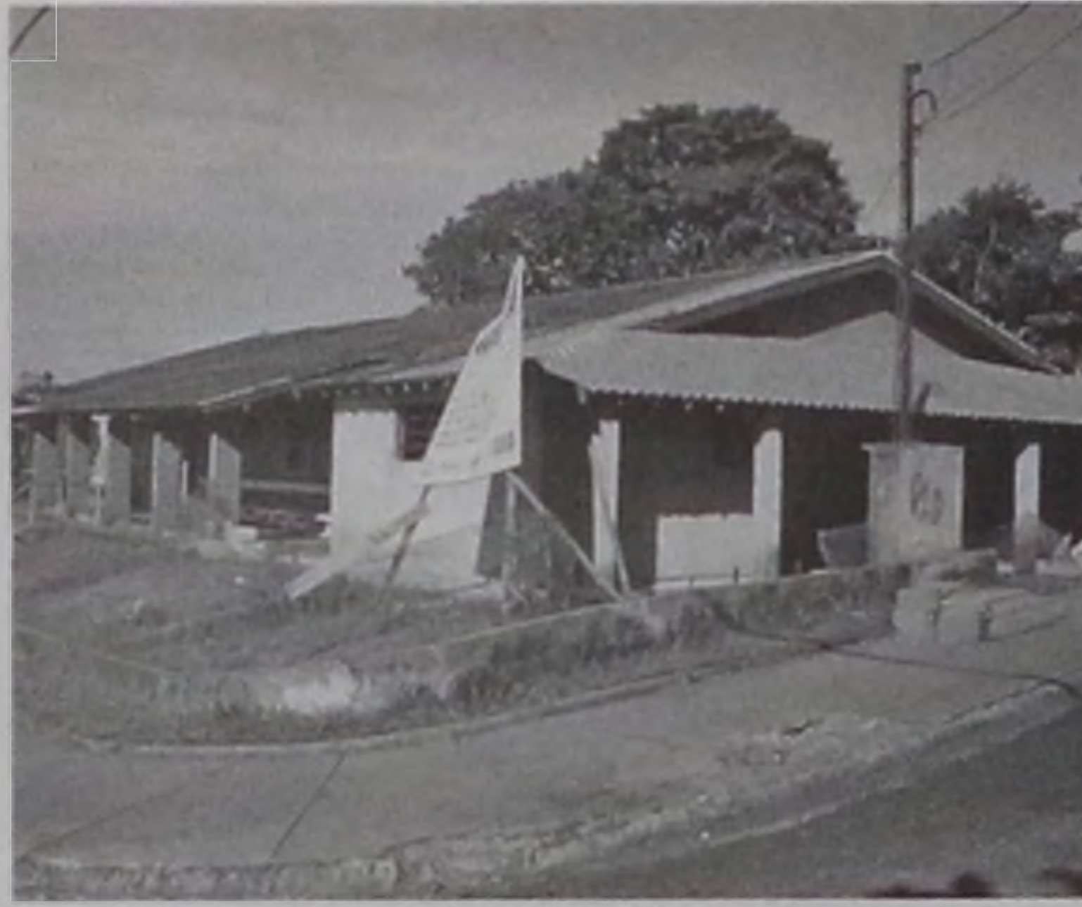
A unidade de saúde do Núcleo Luiz Zillo que deve ter as obras de reforma e ampliação concluídas no início de 2008
