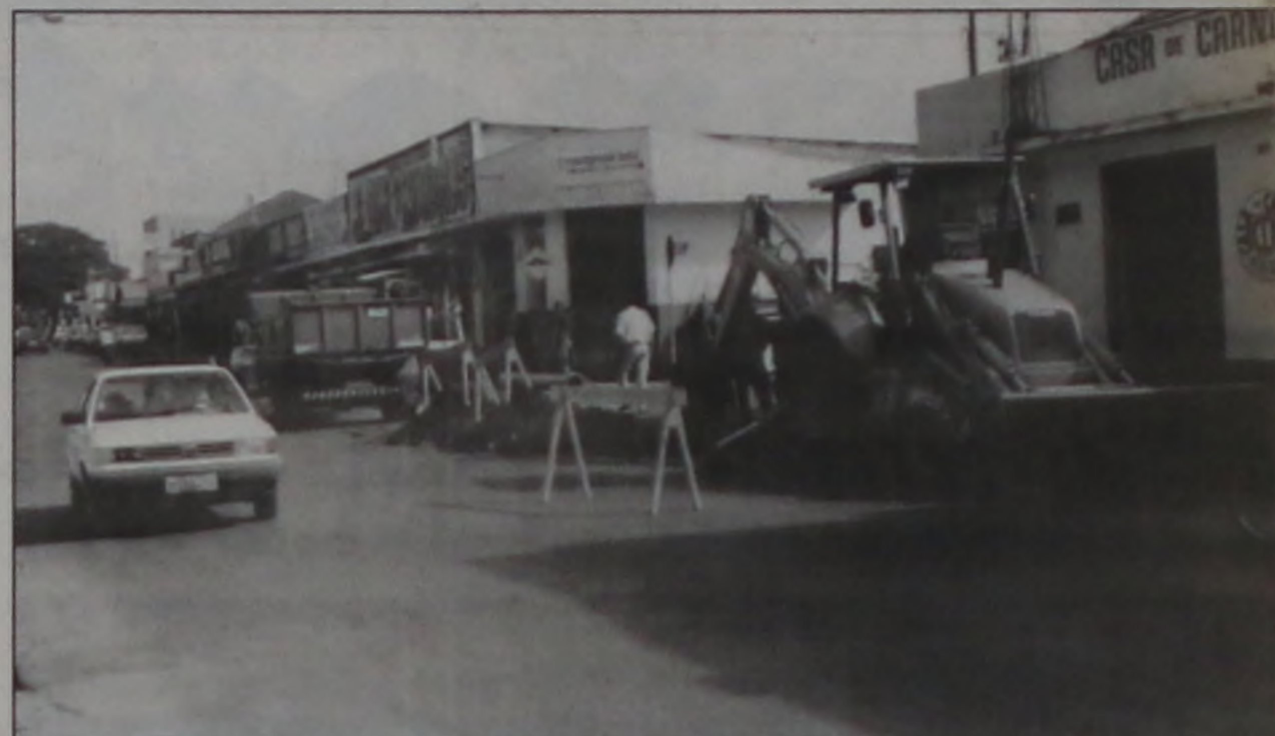
SAAE avança nas obras de implantação da rede adutora
