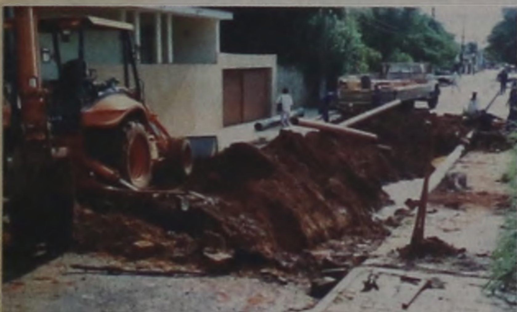
Implantação de rede de adutoras, realizada pelo SAAE
