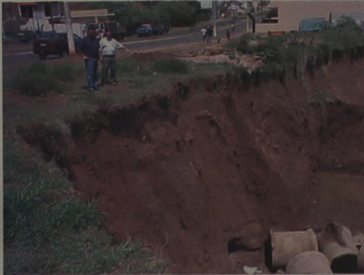
O tão ansiado início das obras da erosão do bairro Maestro Julio Ferrari já tem data marcada. O prefeito Pradinho irá utilizar a verba obtida na venda de terrenos do município, para começar de imediato esta obra. De início serão implantados os tubos de concreto armado, depois construídas as caixas de captação de águas e em seguida o pesado trabalho de aterro, pretendendo o prefeito alcançar um mínimo de 100 m lineares a 200 m, nesta fase.
