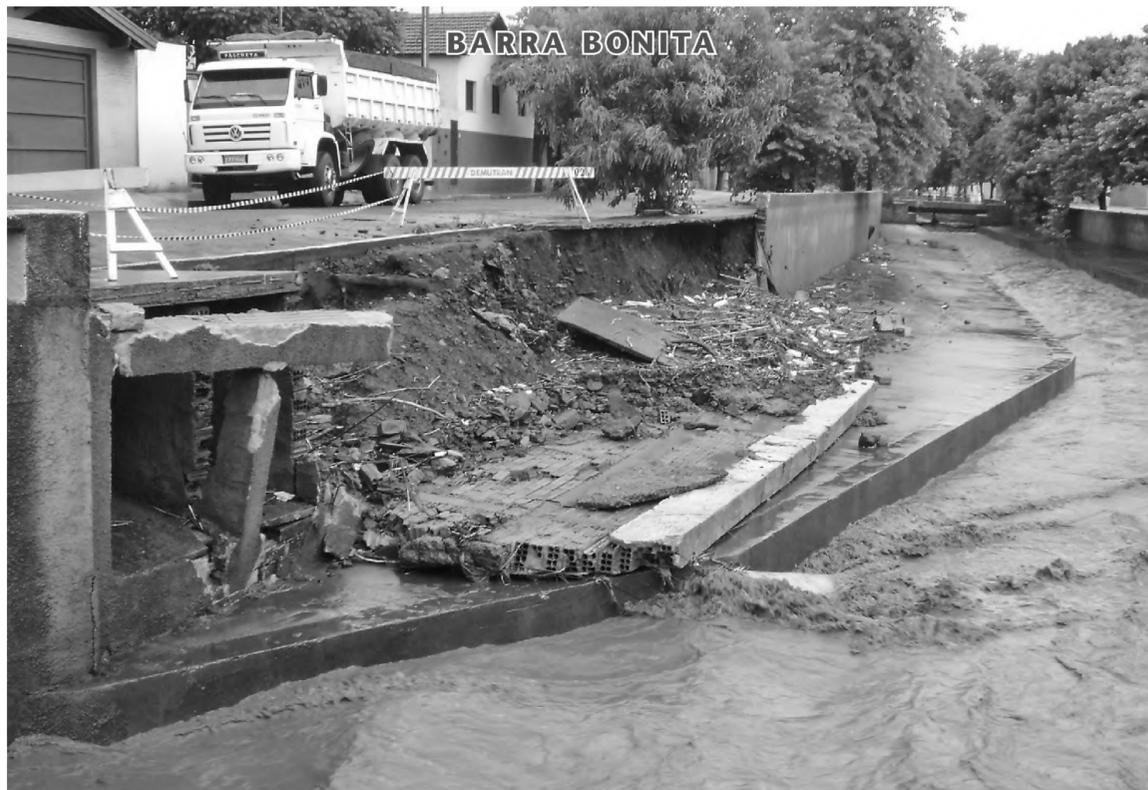
Parede do Córrego Barra Bonita não suportou a força das águas após força da forte chuva na tarde de sábado e desabou
