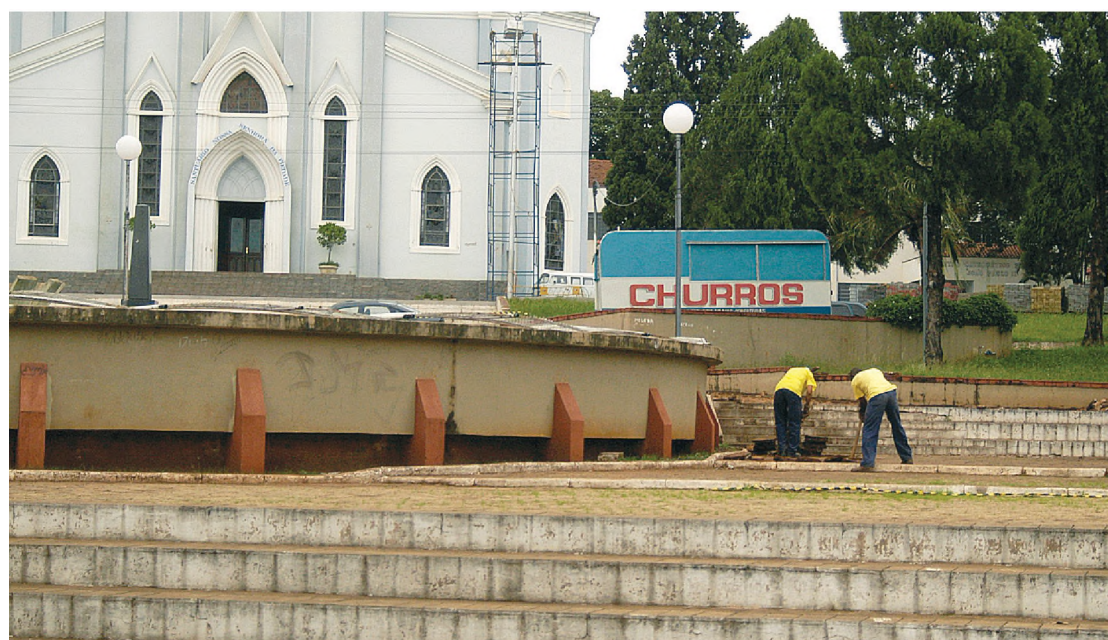
A praça já foi isolada e os operários trabalham na retirada das pedras que serão trocadas
