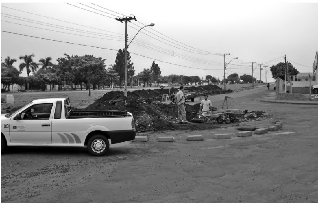
Funcionários trabalham na implantação de galeria nas ruas José Cruzera e Antonio Alves Nunes
