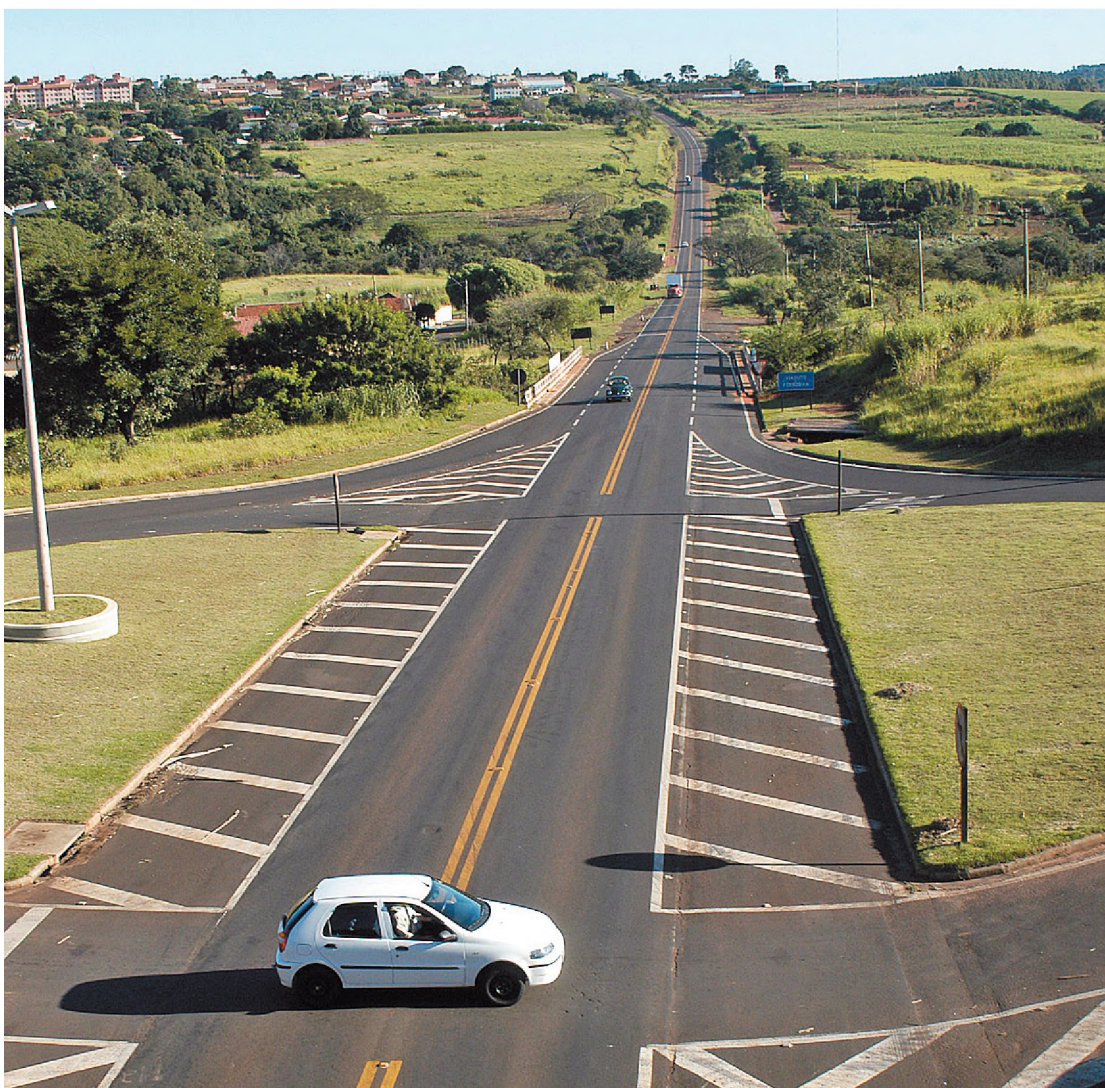
Trecho entre a rodovia Marechal Rondon e a Facol terá acostamento pavimentado e tachões
