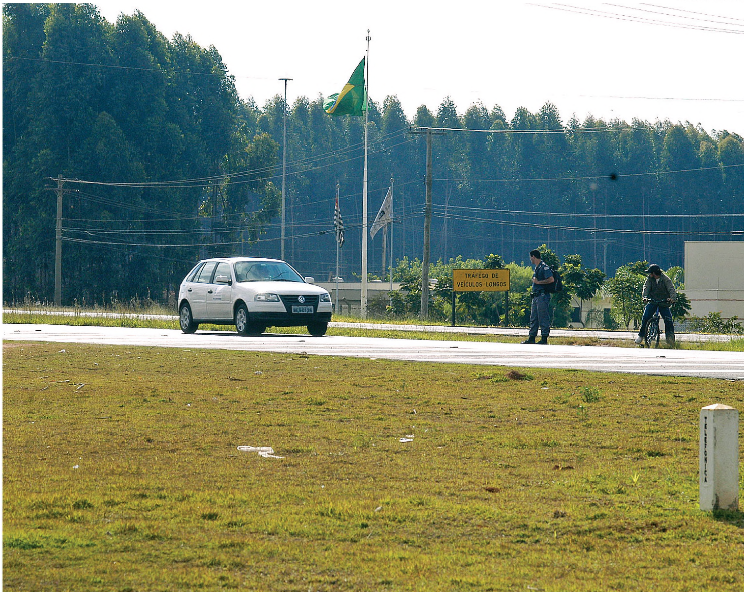
No quilômetro 295 da rodovia Marechal Rondon, a passarela vai facilitar a vida de quem precisa transitar a pé pela região
