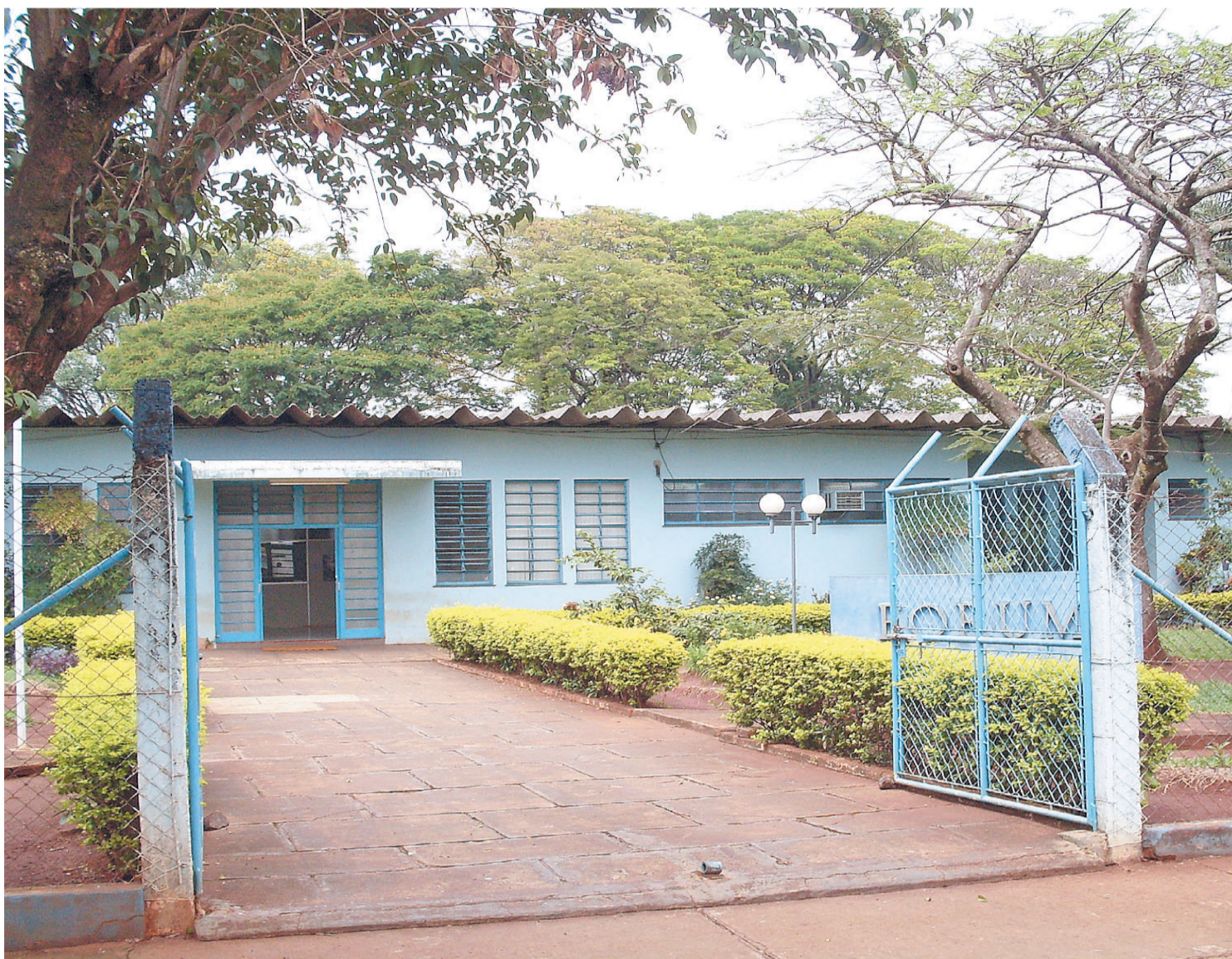
Prédio do fórum deve ficar pelo menos seis meses fechado para reforma; atendimento passa para a escola Padre José Corsini
