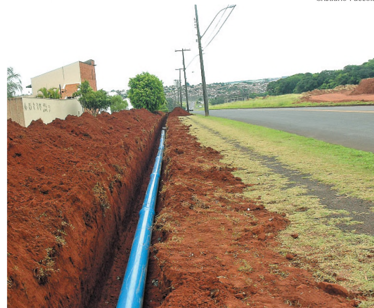
Obra em adutora que abastece a região do Jardim Caju
