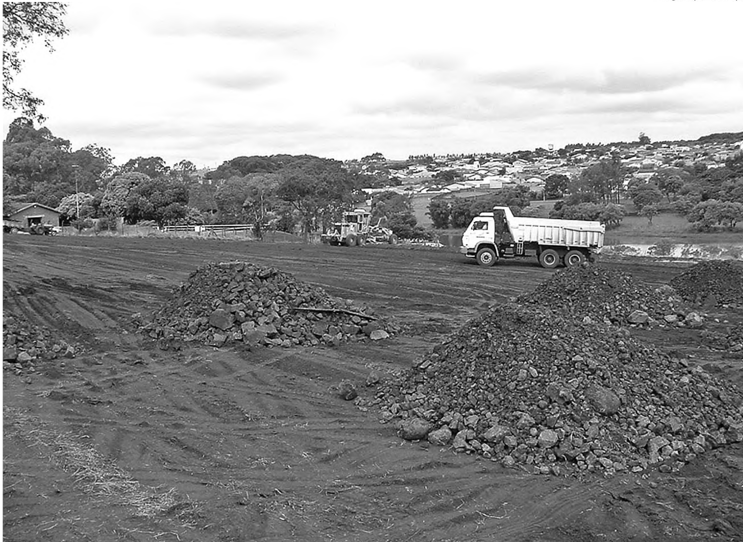
Máquinas pesadas e caminhões trabalham na preparação da área para o novo estacionamento da Facilpa, com 1 mil vagas para automóveis
