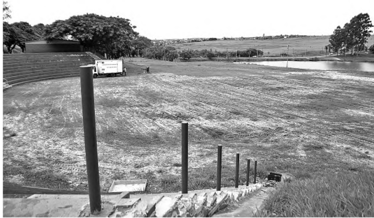
Vista de onde será instalado o palco da Facilpa 2009
