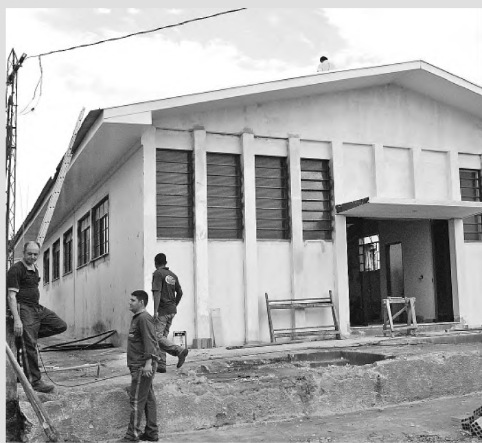
Reforma do prédio que sediará a Câmara já começou
