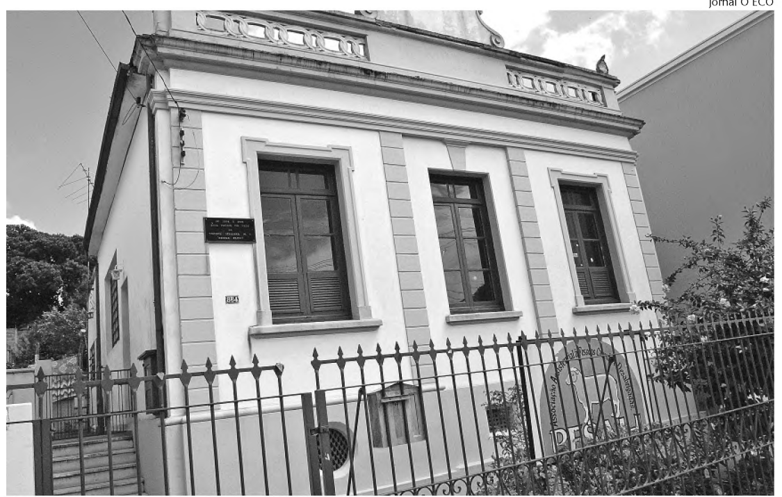
Fachada da Casa de Passagem que pode fechar se não receber repasse da Prefeitura de Agudos
