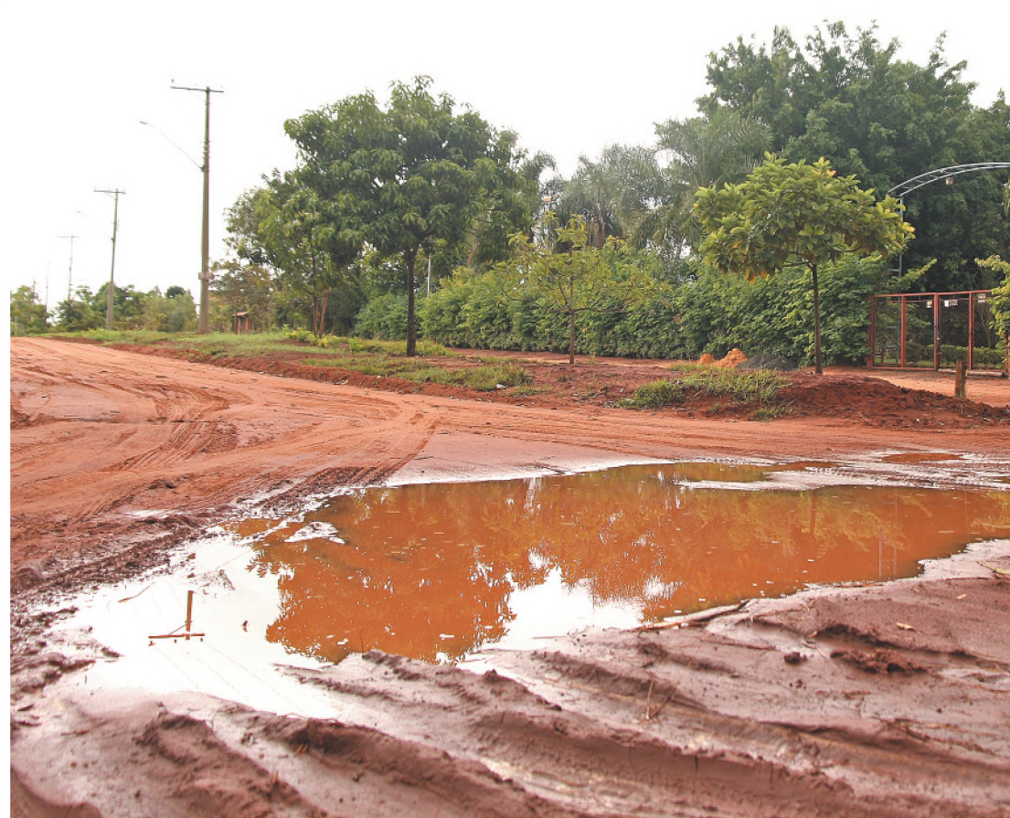
Asfalto vai cobrir apenas a parte central da via, as laterais serão mantidas com grama
