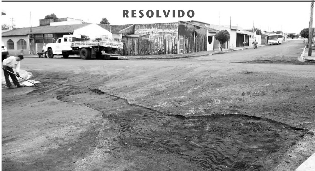
No cruzamento das ruas dos Tucanos com a dos Xupins, no Jardim das Nações, foram feitas galerias de águas pluviais. O mesmo local já esteve nas páginas de O ECO por conta dos buracos provocados pela água das chuvas. Para resolver o problema de vez, a Prefeitura de Lençóis Paulista realizou o serviço de galerias e com isso resolveu o problema em definitivo.
