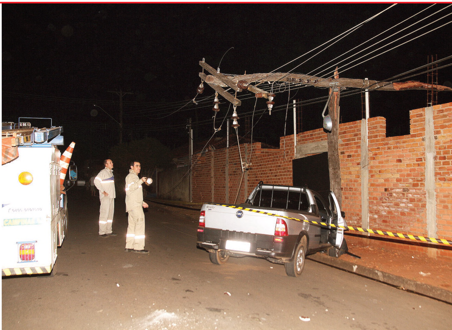
Condutor de Fiat Strada bate em poste, foge e deixa um terço da cidade sem energia elétrica por quase três horas
