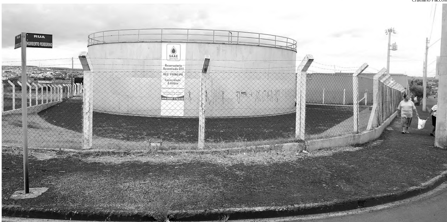
Reservatório de água do Jardim Príncipe, que ajuda no abastecimento da região do Jardim Caju; área precisa de mais investimentos
