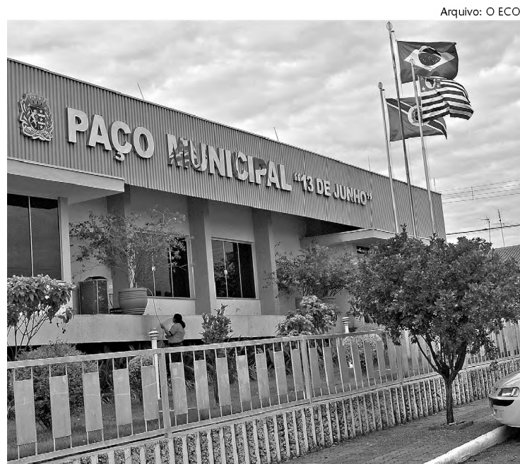
Antena está instalada no prédio da Prefeitura Municipal
