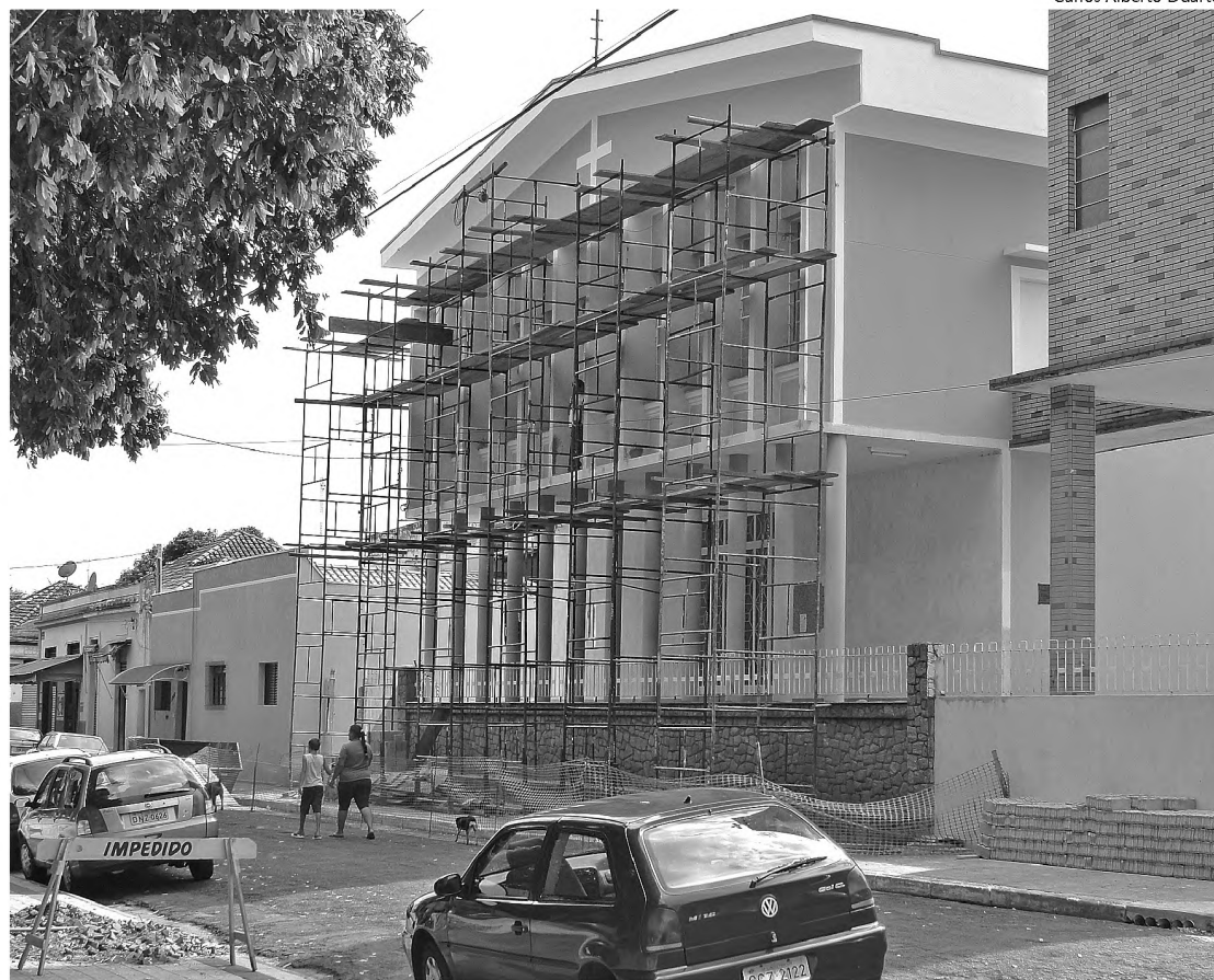
Fachada da igreja matriz de Santo Antonio que está em obras e deve ficar pronta no mês que vem
