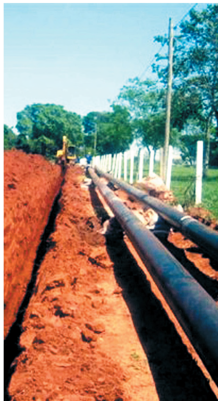
Rede de gasoduto chegou em Pederneiras em 2008
