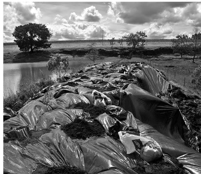
Na represa Fioravante, lonas tentam conter água
