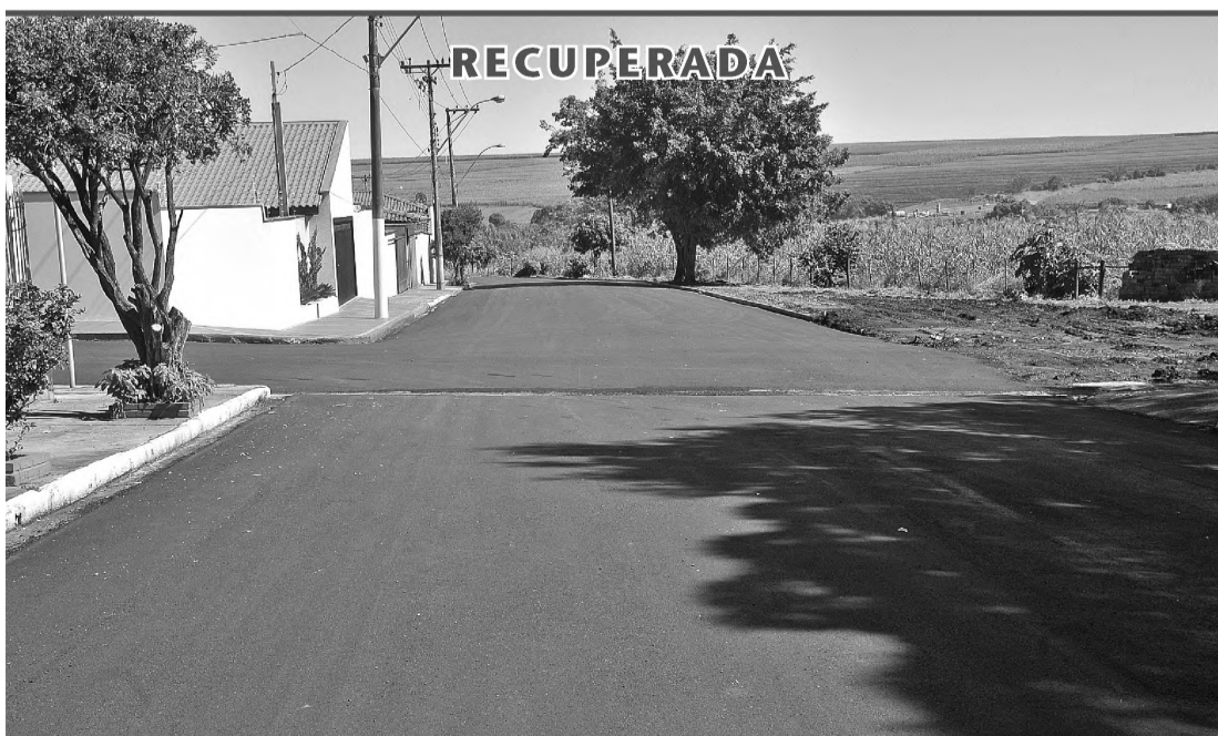
A rua Jacob Daré foi recapeada pela Prefeitura de Macatuba, depois de sofrer danos devido ao desvio de veículos feito à vicinal Lauro Perazzoli, que conduziu o tráfego pesado para a rua.
