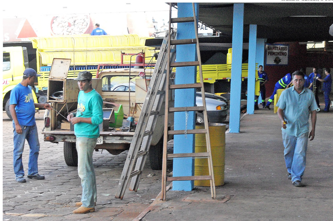
Equipes trabalham para finalizar a montagem do recinto para Feira das Nações
