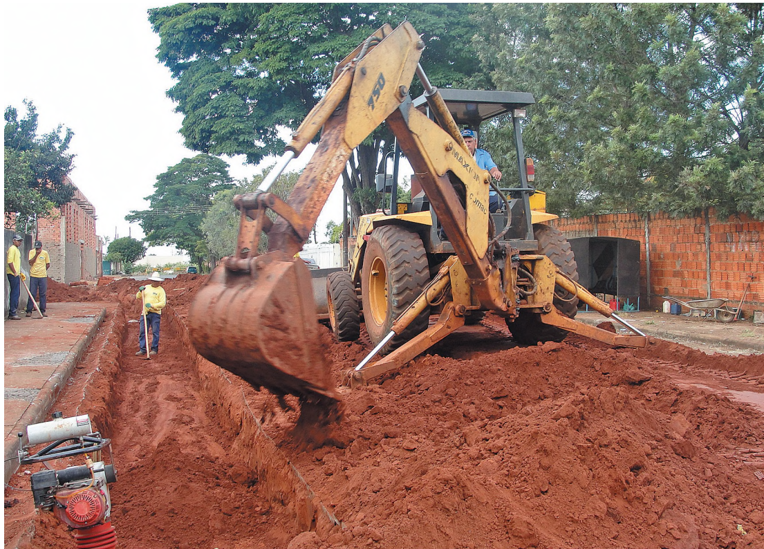
Equipe da Diretoria de Obras realiza obra de galerias pluviais no Jardim Nova Lençóis e Jardim das Nações
