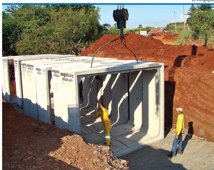
Homens instalam tubos de concreto para canalizar enxurradas
