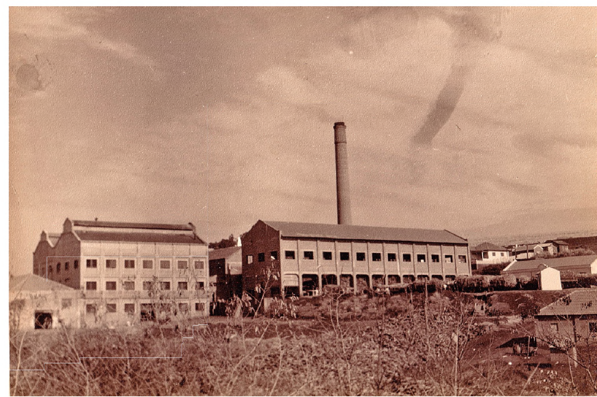
Foto antiga da Usina Barra Grande, reforço importante na estrutura logo nos primeiros anos
