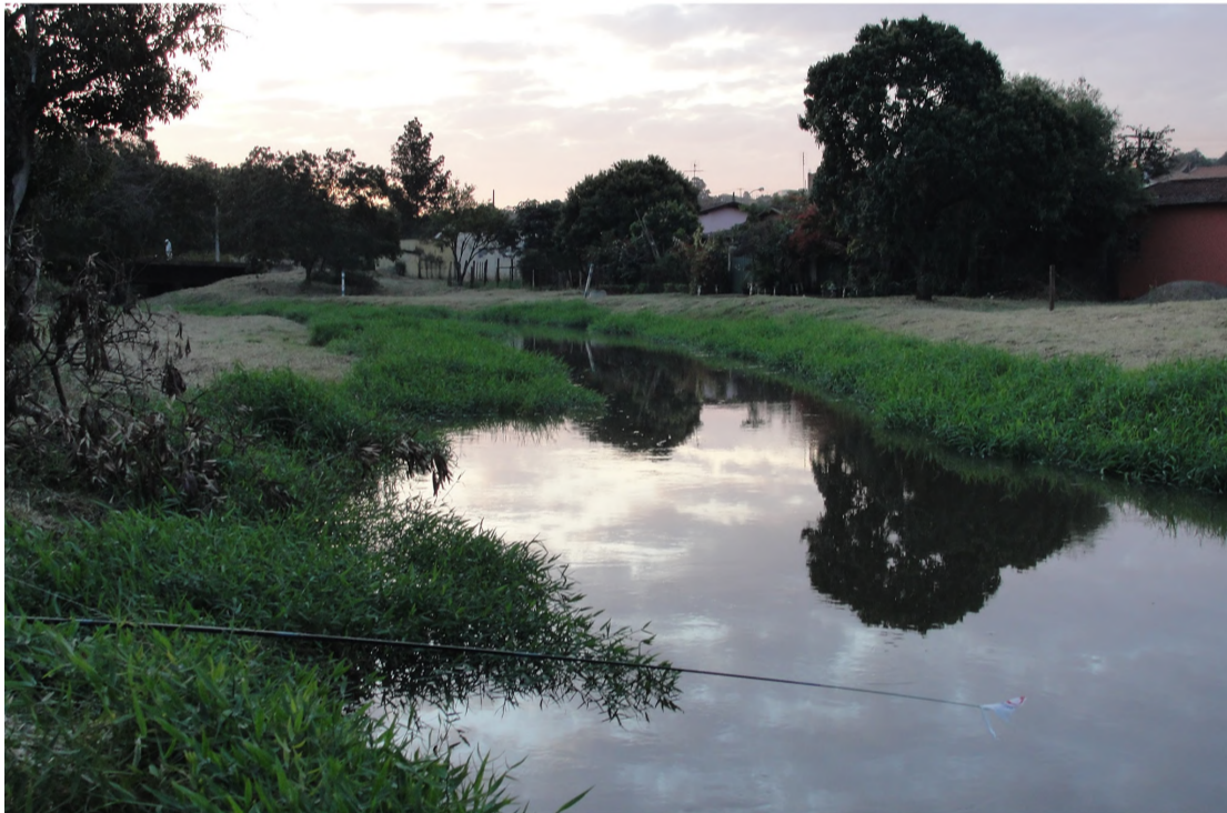
Desassoreamento do rio vai ocorrer entre o SAAE e a ponte de acesso ao Jardim Primavera
