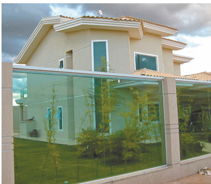
Divisórias no lado externo da casa, muros: vidro temperado com de 10mm espessura
