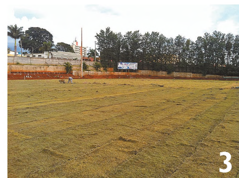
1 - Distribuição de areia para posterior camada de top soil; 2 - Nivelamento a laser, com queda de 0,5% para as laterais facilitando a drenagem; 3 - Plantio da grama bermudas
