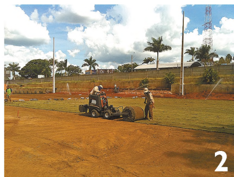
1 - Distribuição de areia para posterior camada de top soil; 2 - Nivelamento a laser, com queda de 0,5% para as laterais facilitando a drenagem; 3 - Plantio da grama bermudas
