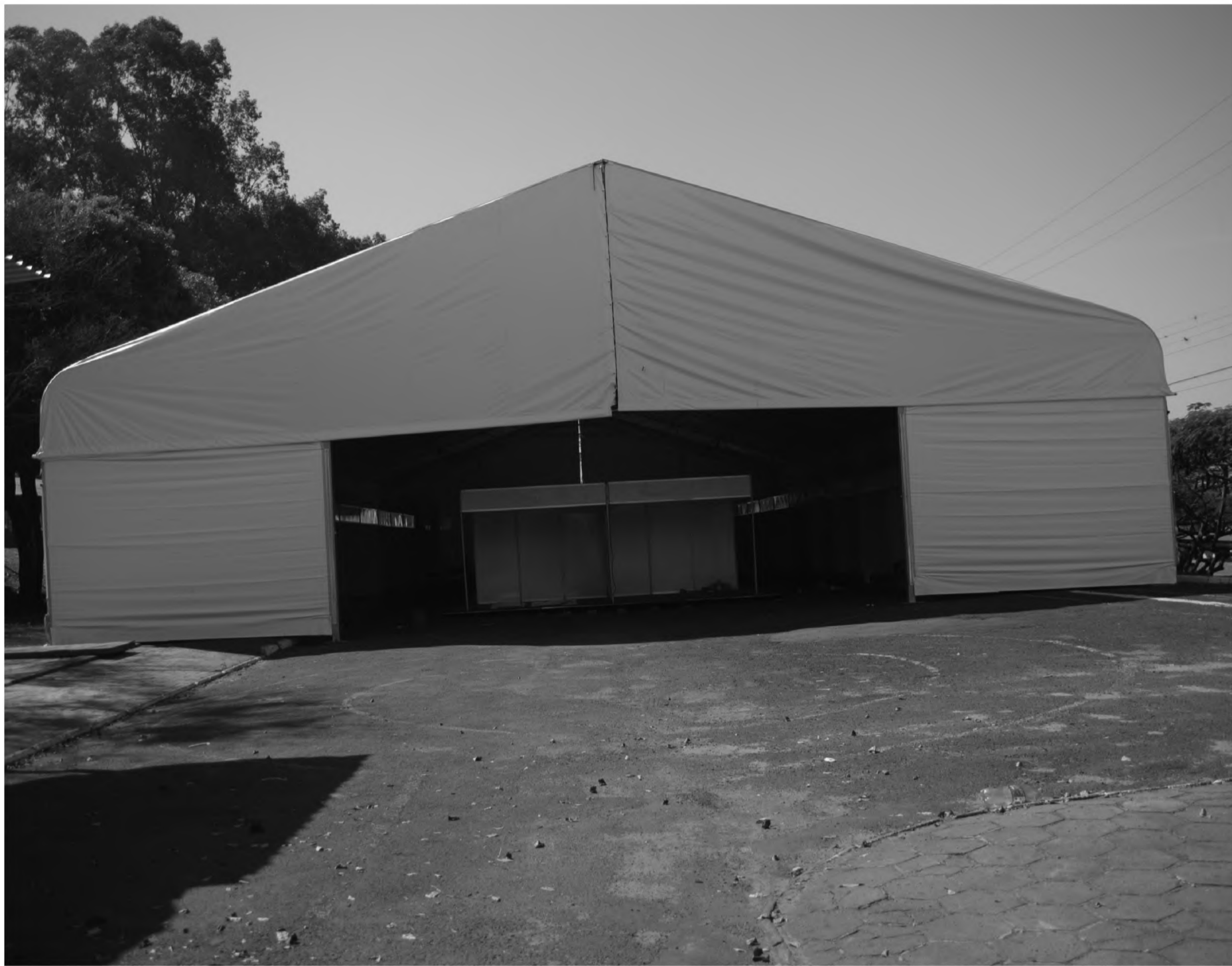
MONTAGEM – Preparativos para a 9ª edição da Agrifam estão a todo o vapor no recinto de exposições José Oliveira Prado, em Lençóis Paulista, que sedia evento pela primeira vez
