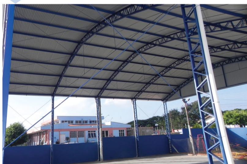
COBERTURA DA ESCOLA MUNICIPAL
