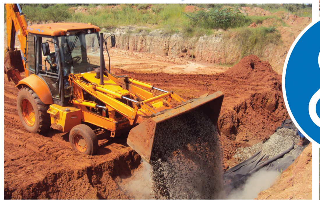
OBRAS DE DRENAGEM NO ESTADIO DE FUTEBOL
