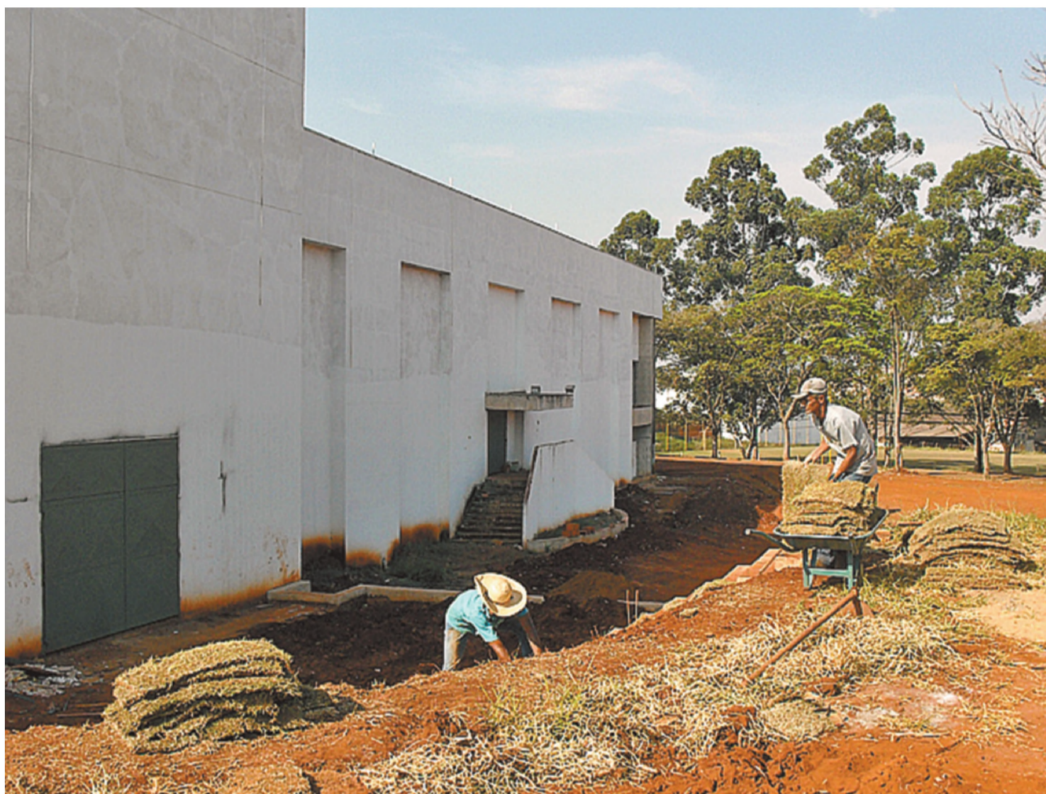
ACABAMENTO EXTERNO – Funcionários colocam grama ao redor do teatro; estacionamento será construído com capacidade para 280 veículos
