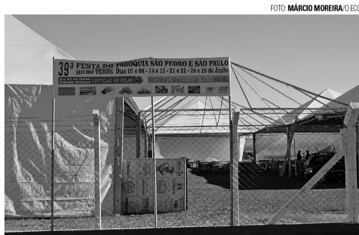
PREPARATIVOS - Barracas sendo montadas na avenida Jácomo Nicolau
